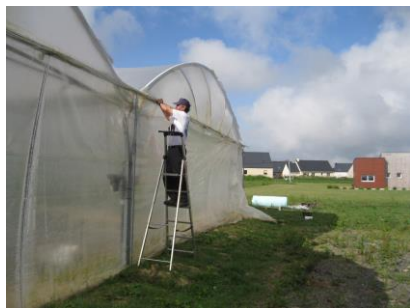
Démontage des portes....
